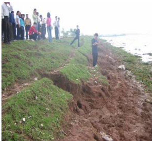
Hình 6. 0,65km đê quốc gia ở xóm Tân Bôi, xã Thái Đô bị xói lở sau cơn bão số 7 vì không có RNM bảo vệ (A); 5km đê ở xã Thái Đô được bảo vệ hoàn toàn không bị sóng do bão số 7 làm xói lở (B)
