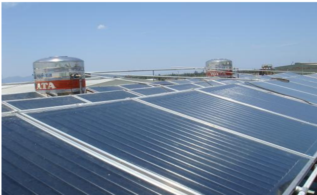
Hình 7. Hệ thống cung cấp nước nóng cho khách sạn 50 phòng.
